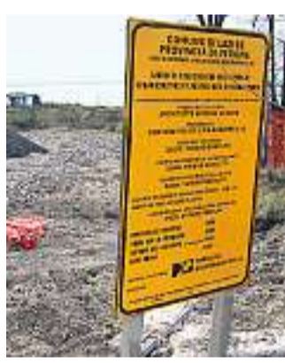
Il cartello che segnala il cantiere
