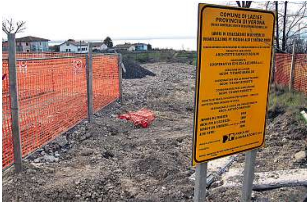
A Pacengo il cartello che informa sui lavori della cooperativa Azzurra per costruire l'albergo-villaggio
